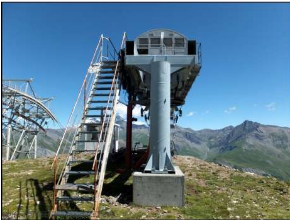
Gare d'arrivée de La Grave. Source : https://www.remontees-mecaniques.net
